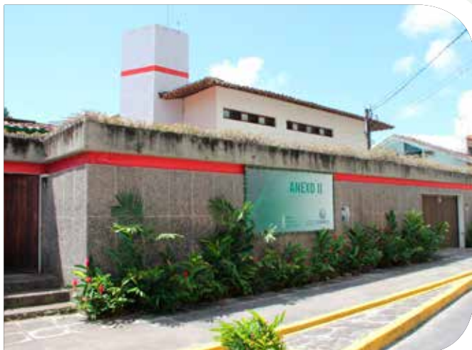
Relocação da Biblioteca Vasconcelos Sobrinho
