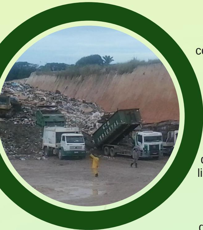
Nas fases iniciais de operação do aterro, a disposição é executada sobre o fundo da célula que deve estar preparada e impermeabilizada com camada de material inerte compactada, além dos sistemas de drenagem de percolados e de gases.
