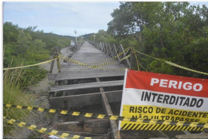
Figura 8.3.2.38 – Píer Mariassu em imagem registrada no dia 6/6/2016. Coordenadas: 25 L 0268655 / UTM 9039747. Fonte: Projetec, 2016 (Autor: Glívio Coelho em 6/6/2016)
