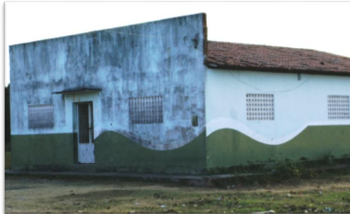
Figura 8.3.2.12 - Clube Municipal de Aver-o-Mar demolido em 2012. Coordenadas: (25 L 271043.54 / UTM 9041656.31). Fonte: Projetec, 2016 (Autor: Glivio Coelho em 4/10/2012)
