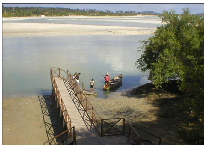
Figura 11. Píer no Rio Jaguaribe – travessia para Praia do Sossego.
