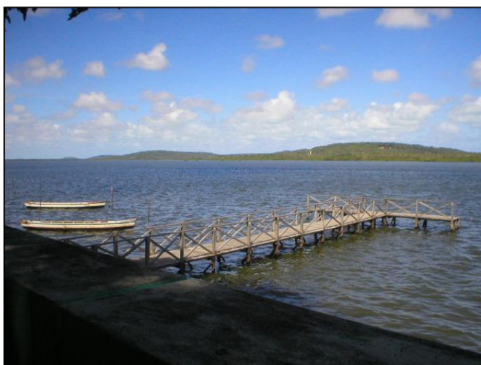
Figura 9. Píer de Itapissuma localizado no Canal de Santa Cruz.
