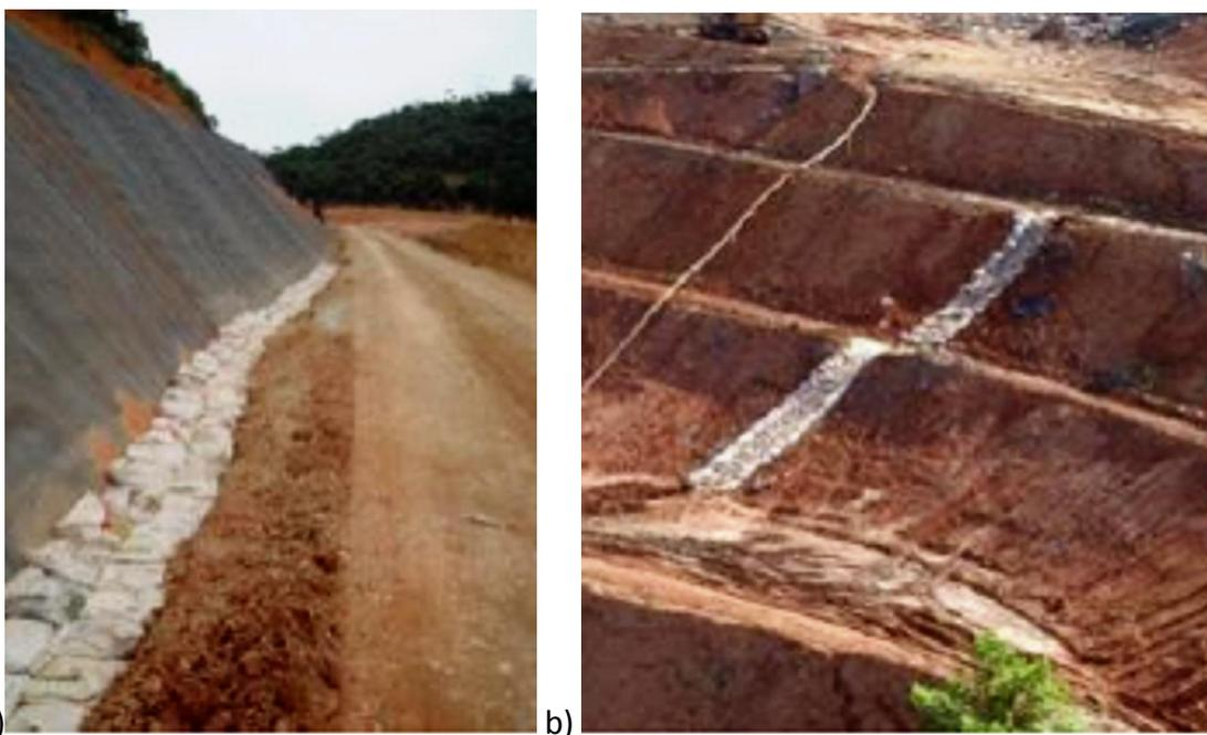
Figura 12. Dispositivos de drenagem: a) Drenagem provisória com sacos de areia na estrada de acesso junto a geomembrana; b) Drenagem provisória com sacos de areia em talude provisório
