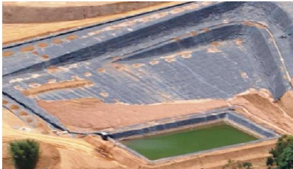
Figura 8. Exemplo da geomembrana lançada na fundação de um aterro sanitário, apresentando a camada de proteção mecânica parcialmente implantada.
