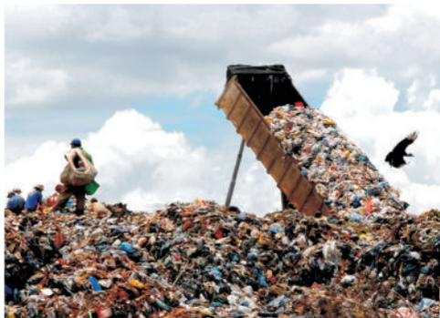
**Aterro sanitário** - Consiste em espalhar e dispor o lixo, alternando-o em camadas, geralmente, com mistura de terra e cascalho. Com o propósito de diminuir o impacto causado ao meio ambiente, também são construídos sistemas de drenagem para gases (metano etc.) e líquidos (conhecido como chorume).
