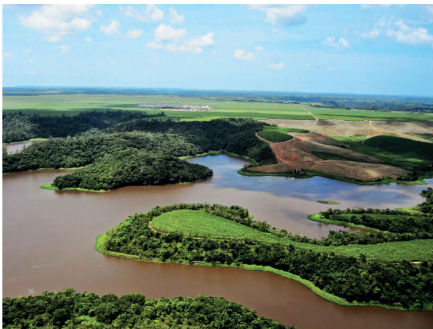
Vista aérea da Barragem de Botafogo – Igarassu/PE. Foto: SECTMA, 2009.
