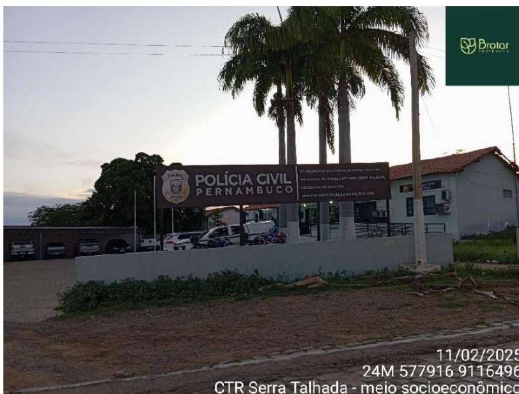
Figura 87. Instalação da Polícia Civil no município de Serra Talhada/PE. Fonte: Brotar Engenharia, 2025.
