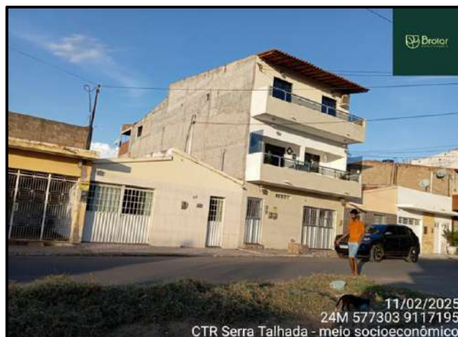
Figura 94. Residência em alvenaria com revestimento cerâmico, pintura e dois pavimentos – Serra Talhada/PE. Fonte: Brotar Engenharia, 2025.
