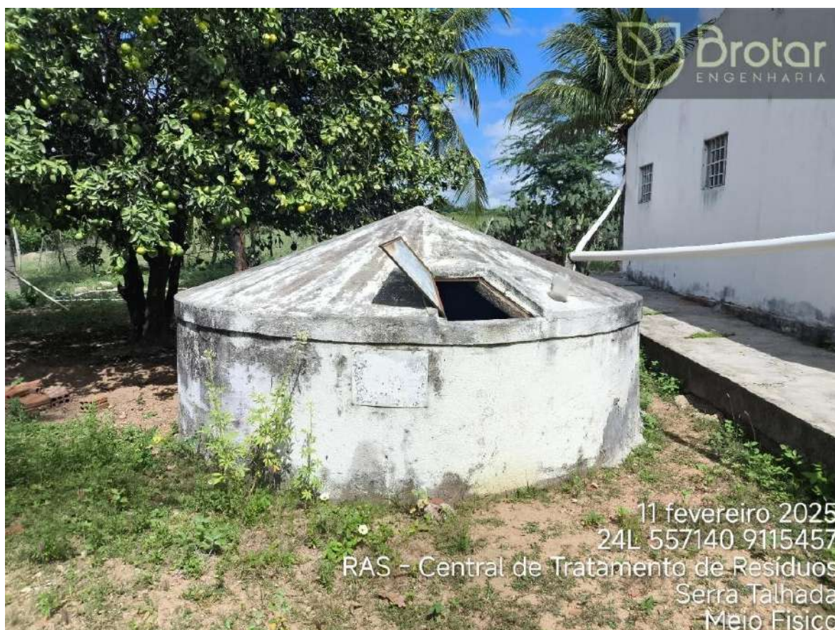
Figura 40. Cisterna utilizada para coletar água da chuva instalada na Área de Influência Indireta (All) do empreendimento. Fonte: Brotar Engenharia, 2025.
