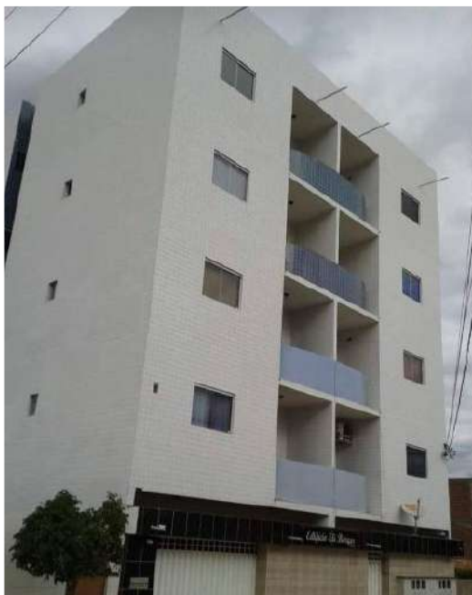
Figura 93. Edifício residencial de quatro pavimentos localizado no município de Serra Talhada/PE. Fonte: Brotar Engenharia, 2025.
