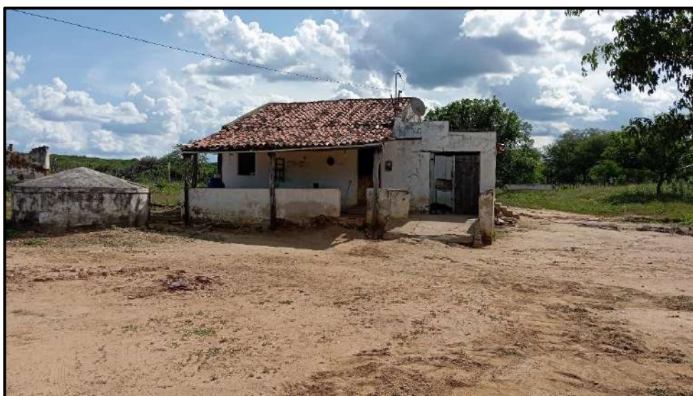
Figura 98. Unidade habitacional localizada nos limites da Área de Influência Direta (AID), pertencente à moradora identificada como dona Cosma, no município de Serra Talhada/PE. A edificação apresenta tipologia térrea, com estrutura em alvenaria e revestimento externo, representando o padrão construtivo predominante na região. Fonte: Brotar Engenharia, 2025.
