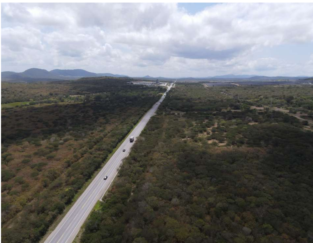
Foto aérea do Trecho 1 da BR-232/PE que passa pelo município de Tacaimbó/PE. Fonte: MRS Ambiental, 2025.
